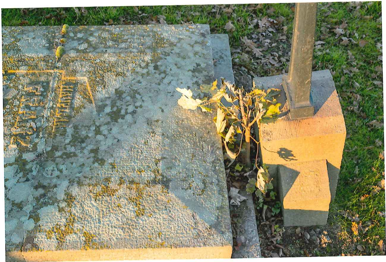
II. 4. Mchy i porosty na kamiennej płycie oraz samosiew przy cokole krzyża nagrobka Franza Dobnika
